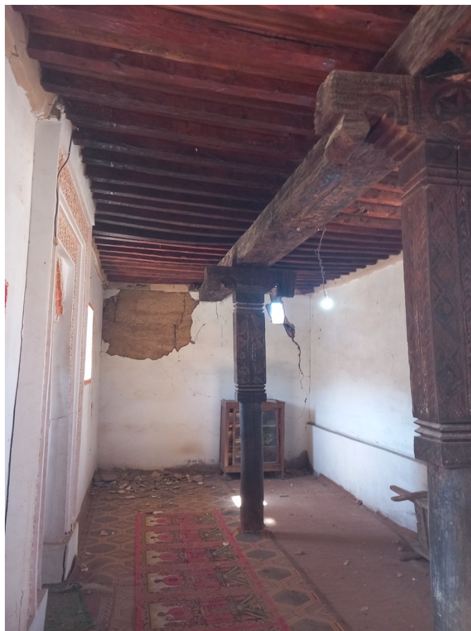
Photo 11. Vieille mosquée du douar d' Afourigh qui date au moins du XIX e siècle, Son plafond en noyer est resté intact. (© Mohamed Tozy)
